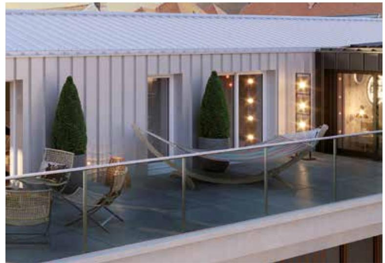
R+4 : béton revêtu d'un bardage en zinc en parement vertical avec continuité en couverture, de teintes différentes
